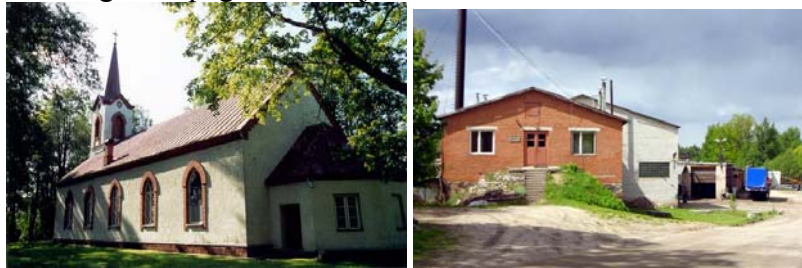
5.6. attēls. Ķempju baznīca un Baptistu lūgšanu nams
