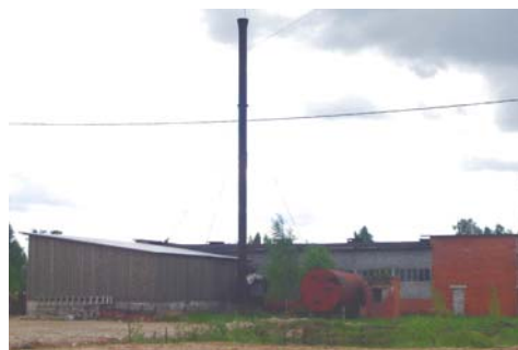
7.6. attēls. Līgatnes pagasta katlumāja
