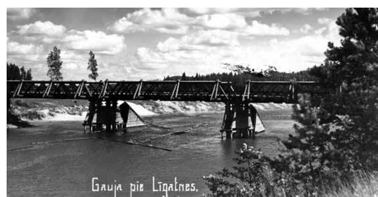
Otrās Līgatnes – Gaujas kroga tilts no 1924.gada 10.oktobra līdz 1941.gada 3.jūlijam
