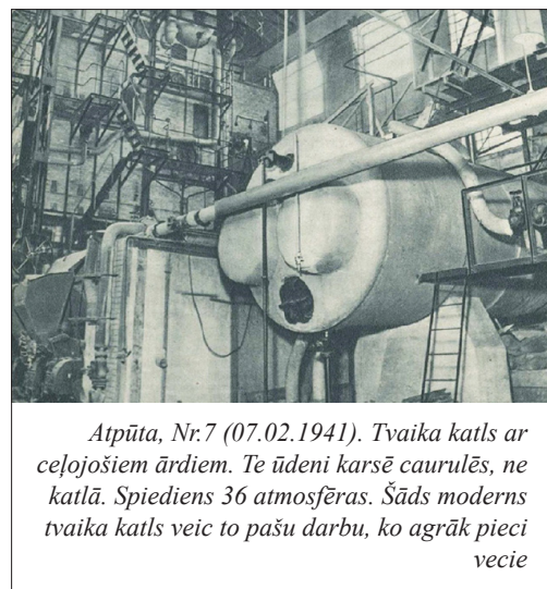
Atpūta, Nr.7 (07.02.1941). Tvaika katls ar ceļojosiem ārdiem. Te ūdeni karsē caurulēs, ne katlā. Spiediens 36 atmosfēras. Šāds moderns tvaika katls veic to pašu darbu, ko agrāk pieci vecie
